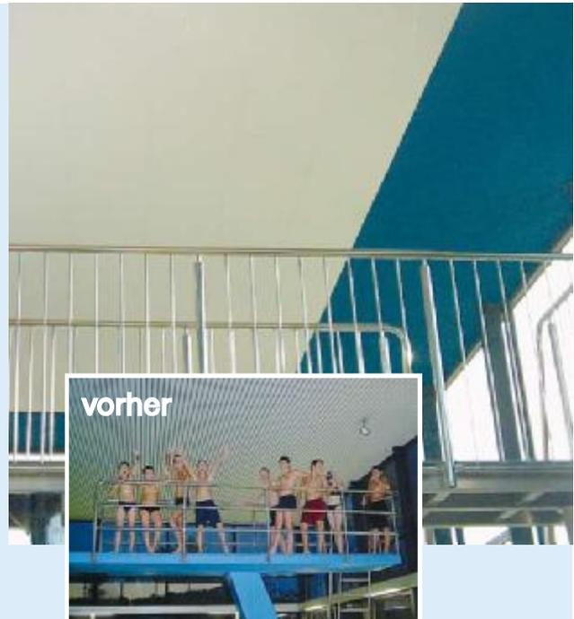
Die Sanierung wurde mit dem **ISO-PLUS-SYSTEM** in Form einer kompletten Lage Wärmedämmung mit absoluter Dampfsperre vorgenommen.
